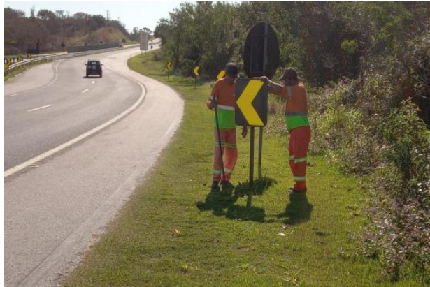
Figura 6.2 Via Lagos – Nivelamento de Placa - Km 34+000 Sul
