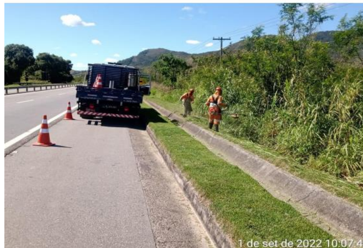
Figura 4.6 Via Lagos – Roçada Manual - Km 12+000 Norte
