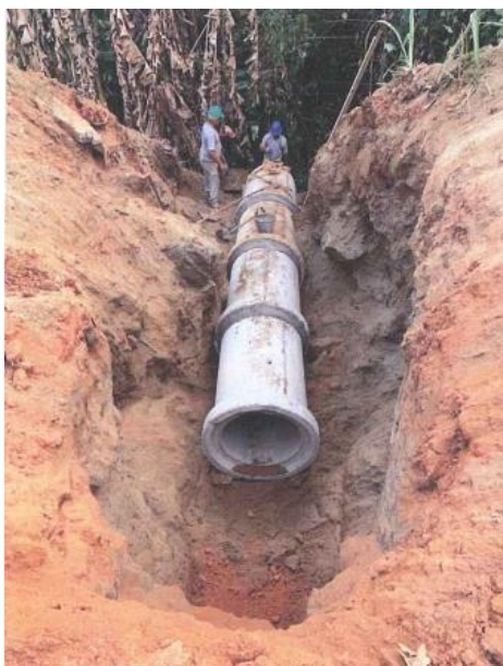
Figura 6.24 Rota 116 - Implantação Drenagem - km 133.5
