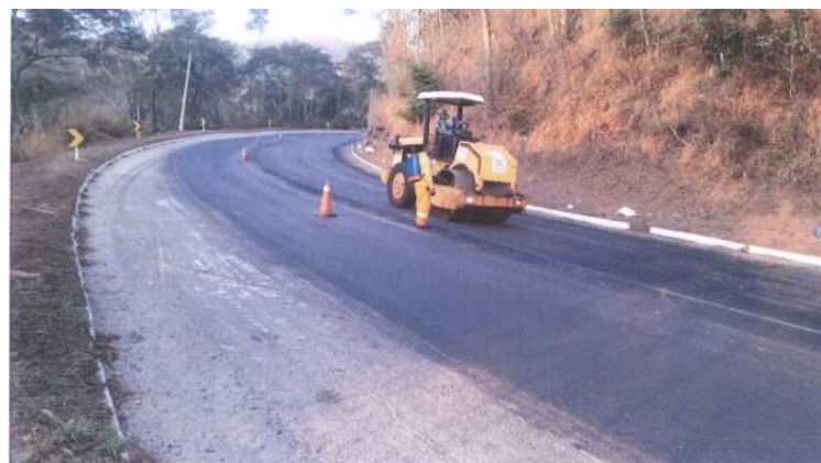
Figura 6.22 Rota 116 – Reparos de pavimento – km 99.5 ao 102
