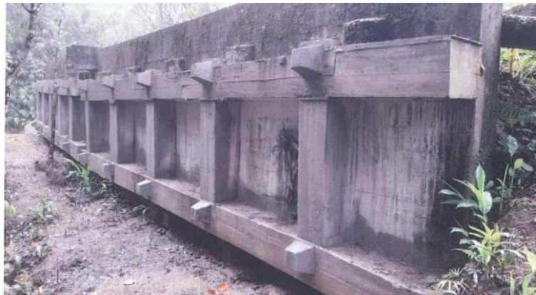
Figura 6.16 Rota 116 – Reforço Muro de Contenção – km 63 Norte
