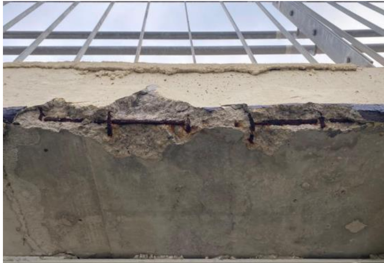
Figura 6.11 Via Lagos – Tratamento de OAEs concreto desagregado - Km 03+250
