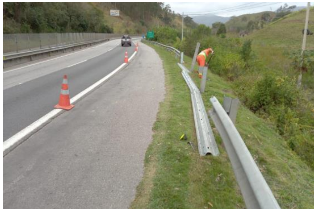
Figura 4.3 Via Lagos - Dispositivo de Segurança - Km 6+900 Norte
