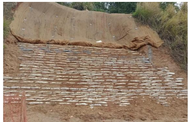
Figura 6.14 Via Lagos – Talude de Corte - Km 5+000 Norte
