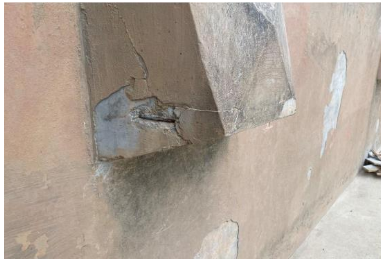
Figura 6.12 Via Lagos – Tratamento de OAEs concreto desagregado - Km 31+150 Norte
