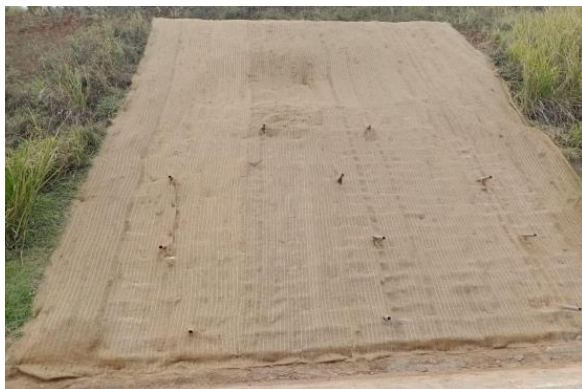
Figura 6.13 Via Lagos – Talude de Corte - Km 7+300 Sul
