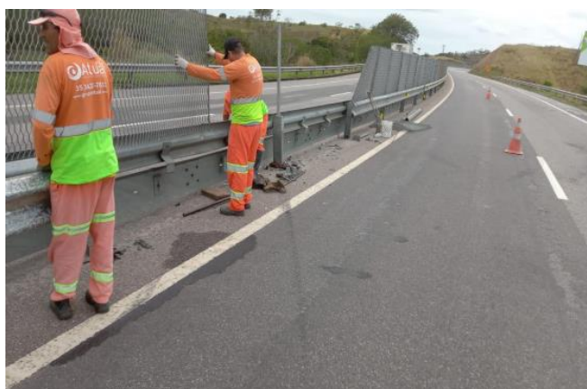
Figura 6.4 Via Lagos - Dispositivo de Segurança - Km 38+700 Norte
