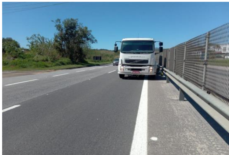
Figura 6.9 Via Lagos – Varrição de Mediana - Km 3+400 Sul
