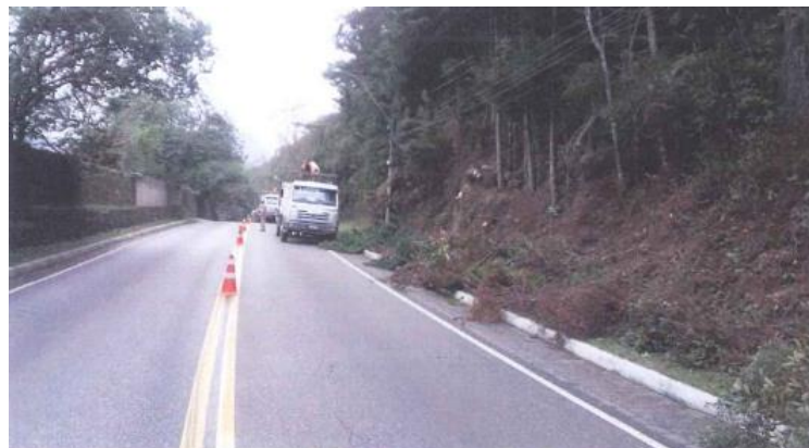
Figura 6.17 Rota 116 – Serviços de Poda – Km 68
