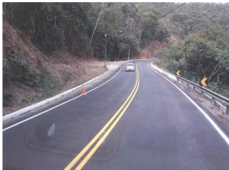
Figura 6.18 Rota 116 – Reparos de pavimento – km 85 ao 87
