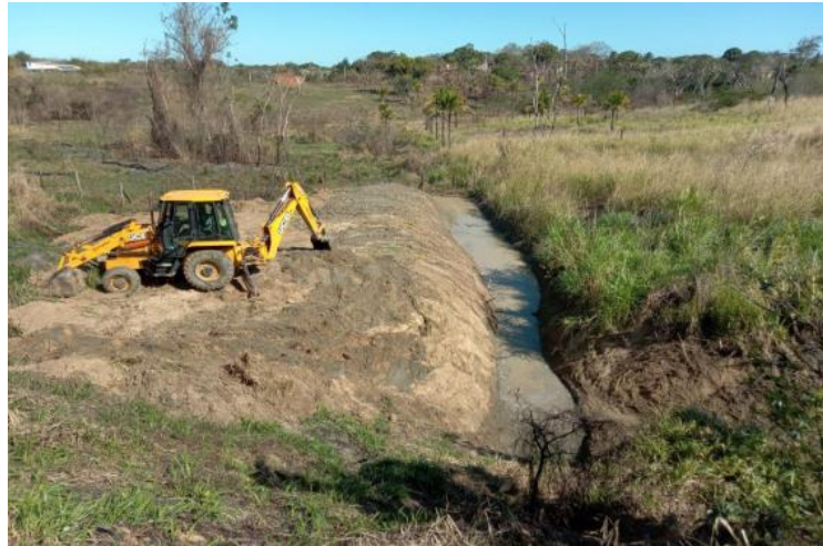
Figura 4.5 Via Lagos - Limpeza de Bueiro - Km 35+800 Norte
