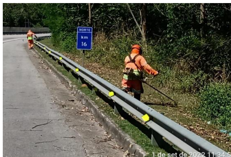
Figura 6.7 Via Lagos - Roçada Manual - Km 16+000 Norte
