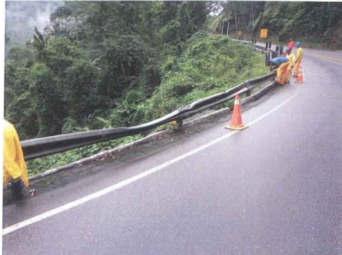
Figura 6.15 Rota 116 – Reparo dispositivo de segurança – Km 54 Sul
