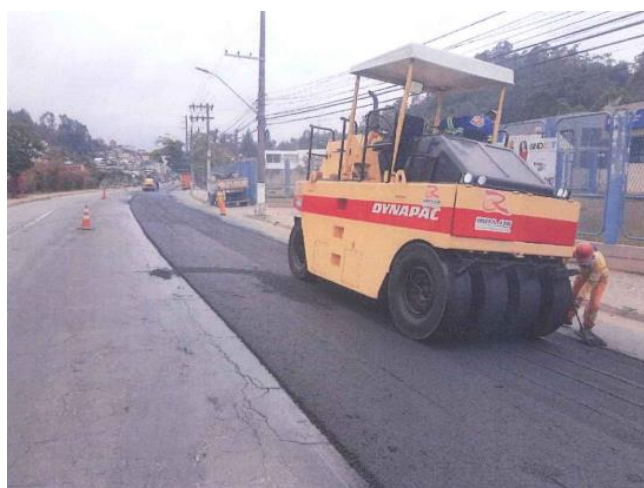
Figura 6.19 Rota 116 – Reparos de pavimento – km 85 ao 87
