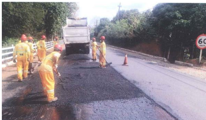
Figura 6.23 Rota 116 - Reparos de Pavimento - km 137.5
